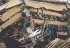
I. Depremde binaların yıkılması
